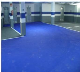
**ARS-FLOOR CLD** es una resina de altas prestaciones a base de poliuretano monocomponente alifático, que reacciona con la humedad ambiental con alta resistencia a la abrasión y a los agentes químicos
